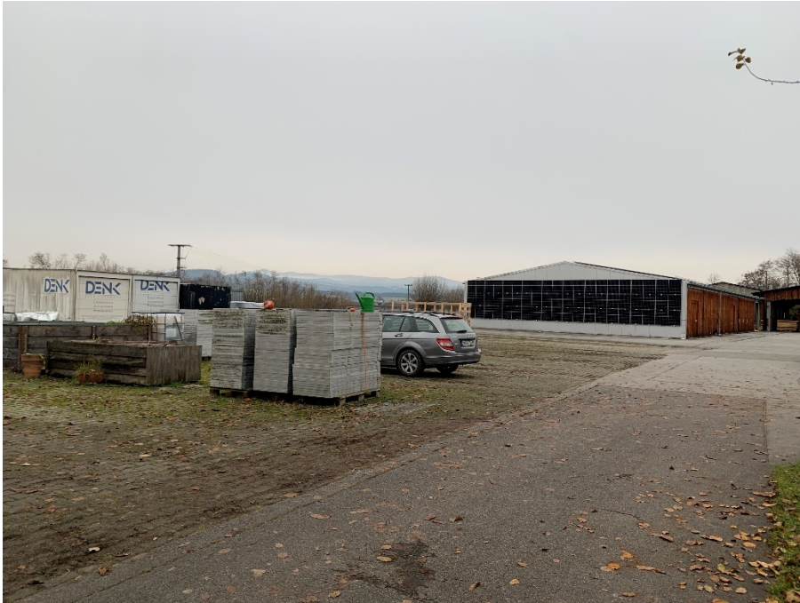
Abb. 6: Ansicht von Südwesten – Betriebsgebäude und Lagerflächen, Foto Jocham + Kellhuber (Dezember 2022)
