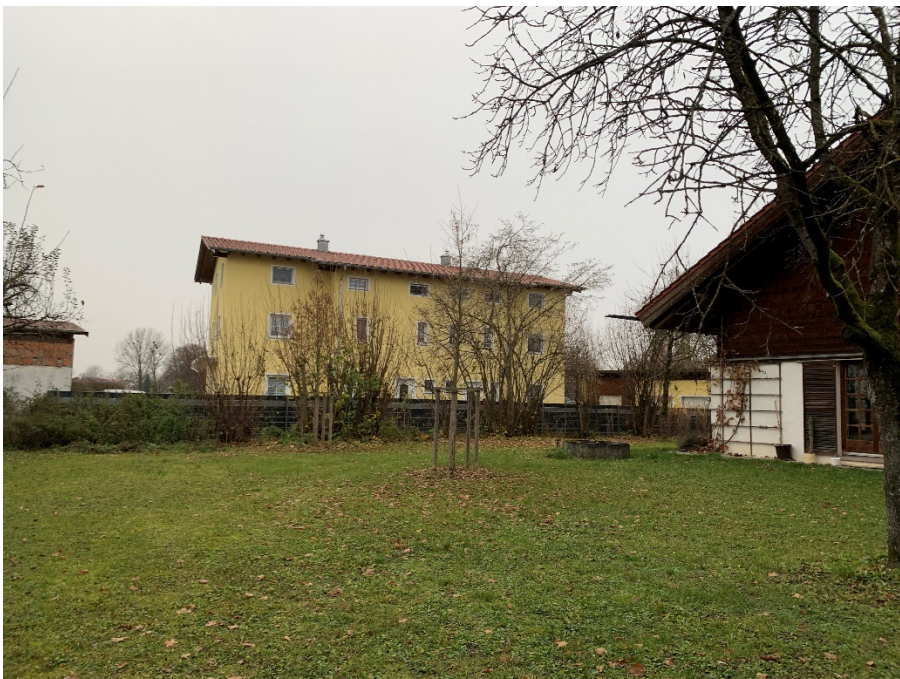
Abb. 7: Ansicht von Nordosten – Privatgarten und Nachbargebäude Foto Jocham + Kellhuber (Dezember 2022)
