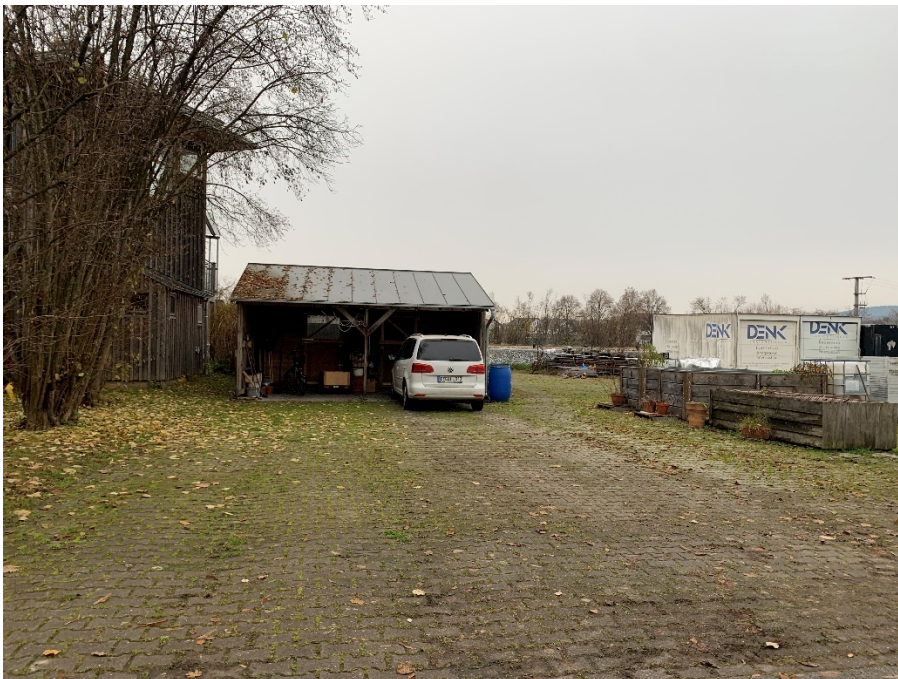
Abb. 5: Ansicht von Südosten – Garage Betriebsleiterwohnhaus, Foto Jocham + Kellhuber (Dezember 2022)
